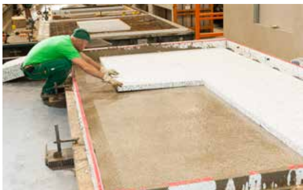
Rivestimento della lastra esterna, fresca di getto, con le lastre isolanti.
