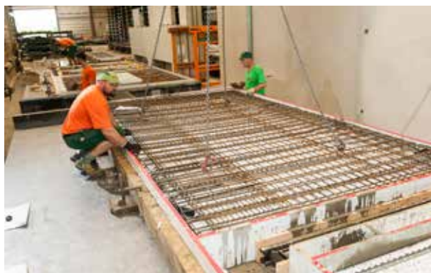
Installazione dell'armatura per la struttura portante.
