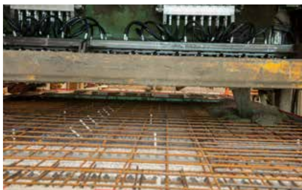
Getto del calcestruzzo della struttura portante.
