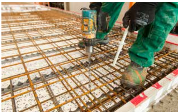
Realizzazione di fori nello strato isolante.
