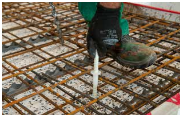
Inserimento di Schöck Isolink® tipo TA-HC nello strato isolante precedentemente perforato.
