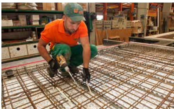
Impiego, a seconda del caso, delle barre diagonali (Schöck Isolink® TA-DC).
