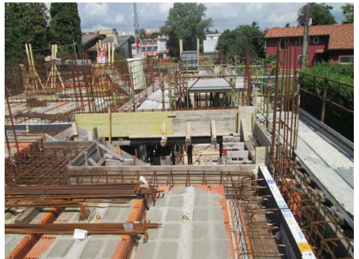
Dettagli posa del giunto isolante Schöck Isokorb® in corrispondenza delle terrazze dei tre edifici in progetto
