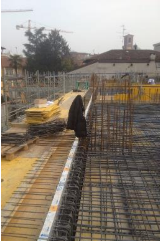
Foto5-6: Posa in opera dei giunti isolanti Isokorb® ©Alvaro Siza Architetto
