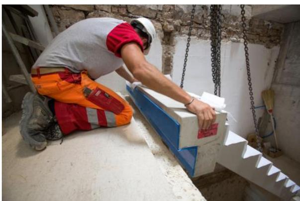
Foto 2: Tronsole® è compatibile e può essere applicato con qualsiasi tipo di opera, sia con scale diritte che a chiocciola (Foto Schöck Italia)
