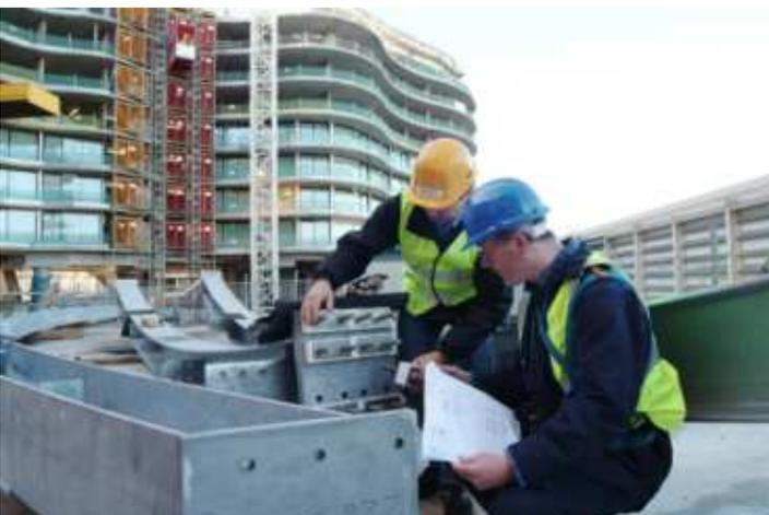
Foto 3: edificio “Albion Riverside” (Londra) - montaggio di Schöck Isokorb® KST al supporto in acciaio
