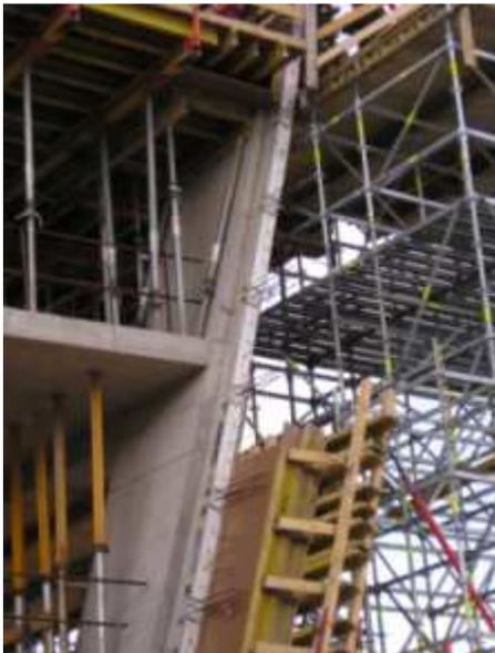
Foto 2: edificio “Bonner Bogen” - per il taglio termico degli archi e della facciata sono stati utilizzati i giunti isolanti Isokorb® di Schöck
