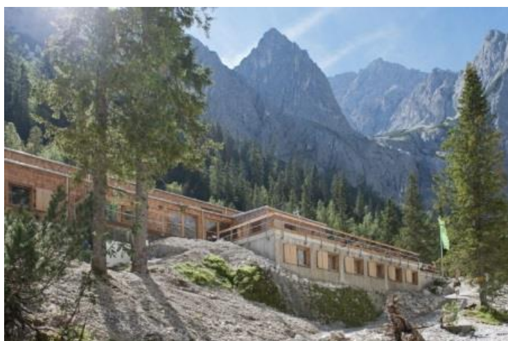
Foto 2: Il seminterrato è stato realizzato con pannelli prefabbricati e gli elementi di armatura Schöck Thermoanker per assicurare un perfetto isolamento termico (Foto Schöck)
