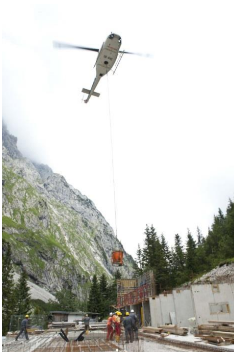
Foto 3: Il materiale da costruzione è stato trasportato in quota con l'ausilio di un elicottero (Foto Schöck)
